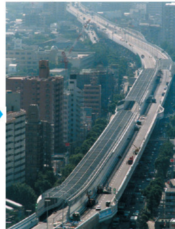
復旧した高速道路 (平成 8 年 9 月) Restored highway (September 1996)
