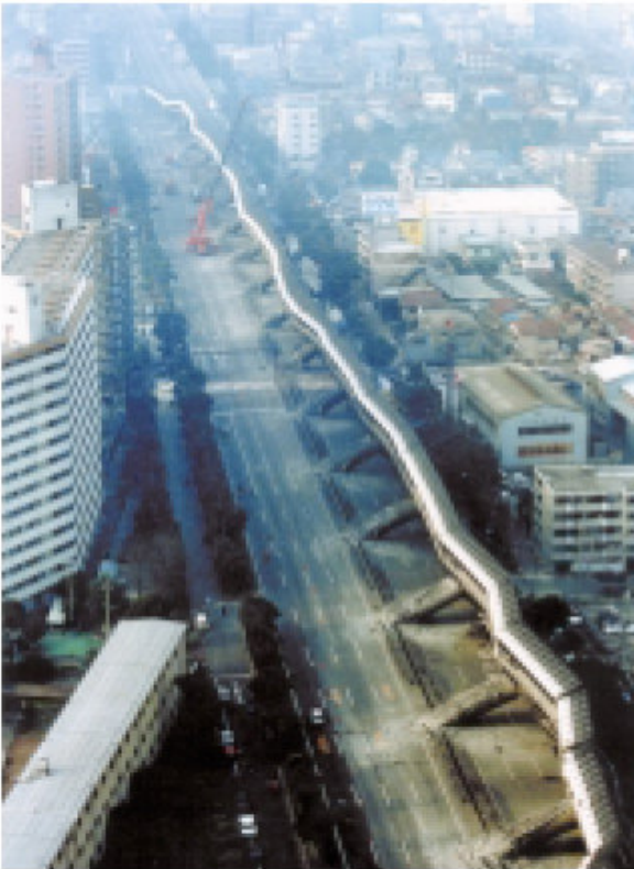
高速道路の崩壊 (平成 7 年 1 月) Collapsed highway (January 1995)
