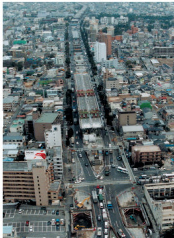
高速道路の復旧工事 Restoration work on the highway
